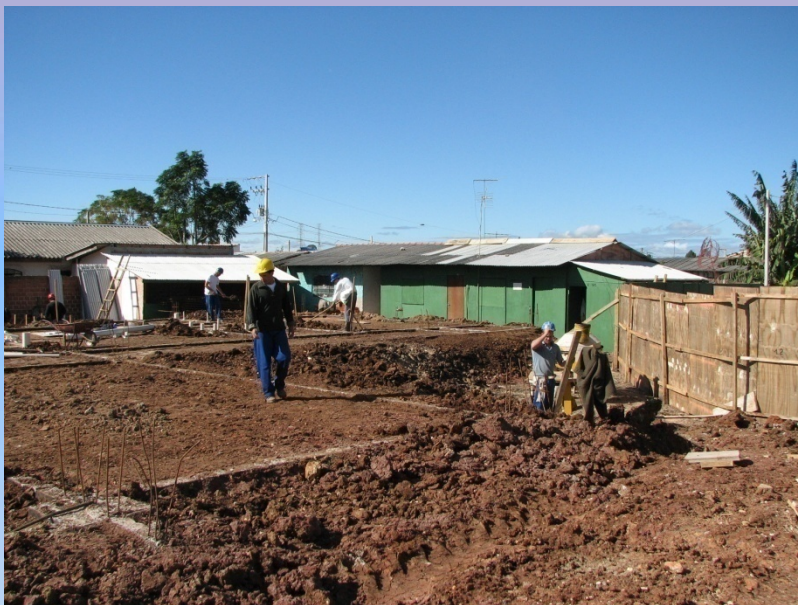
Creche em construção
