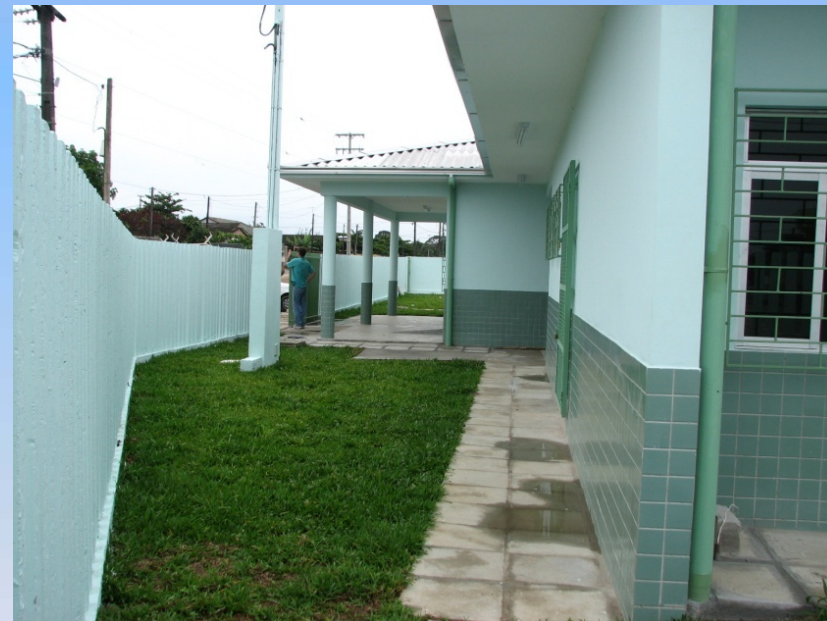
Posto de Saúde concluído
