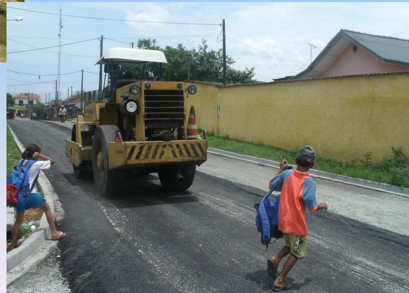
Asfaltamento de vias | 2010
