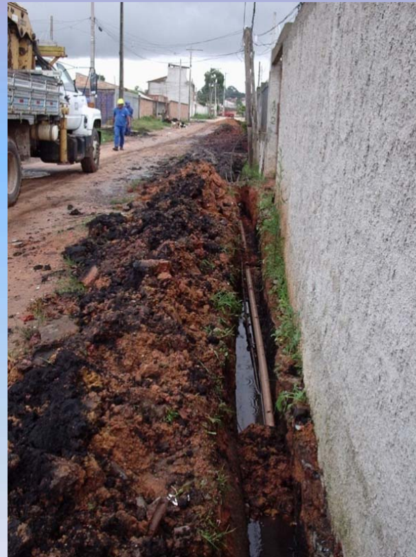
Implantação da rede de água regular
