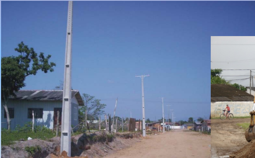
Implantação rede de energia elétrica
