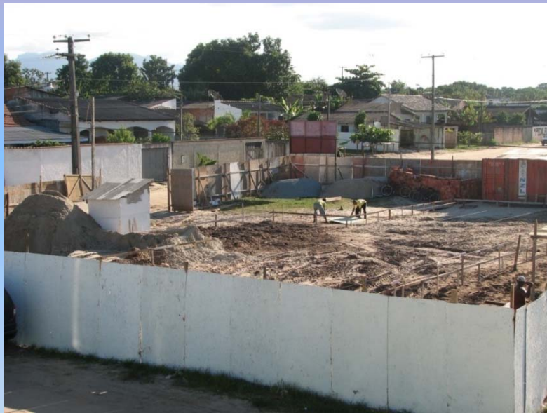
Posto de Saúde em construção
